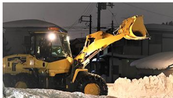
＜除雪作業の様子＞
