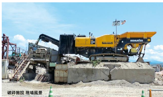
＜アスガラ・コンガラの破碎処理＞
