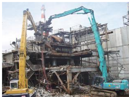
＜コンビネーション解体の様子＞
