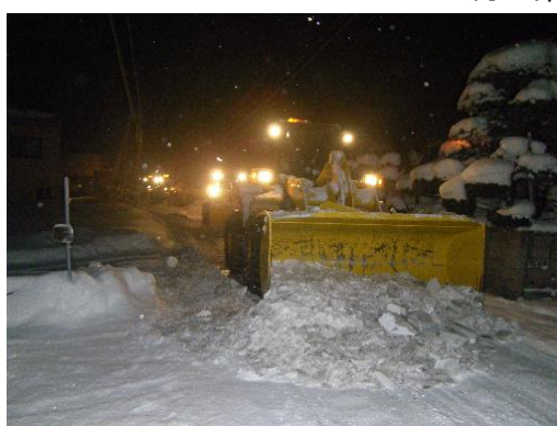
＜除雪作業の様子＞
