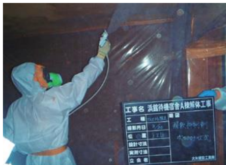
＜アスベスト除去作業＞
