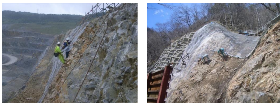
＜法面工事の様子＞
