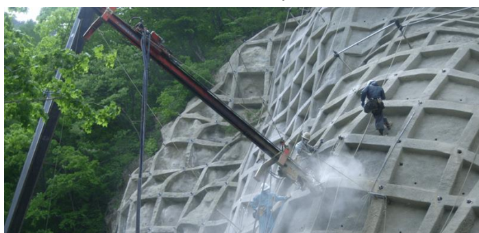
＜法面工事の様子＞
